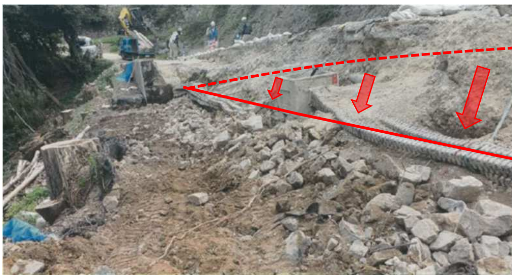
写真 2 7 : 施工状況①
