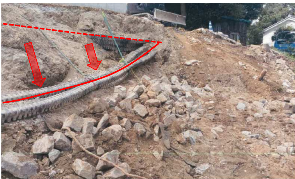
写真 2 8 : 施工状況②
